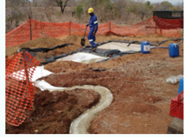
Sondaj çalışmaları için havuz sistemi ve çevre güvenliğinin alınması. The provision of a pool system and environmental safety for drilling operations
