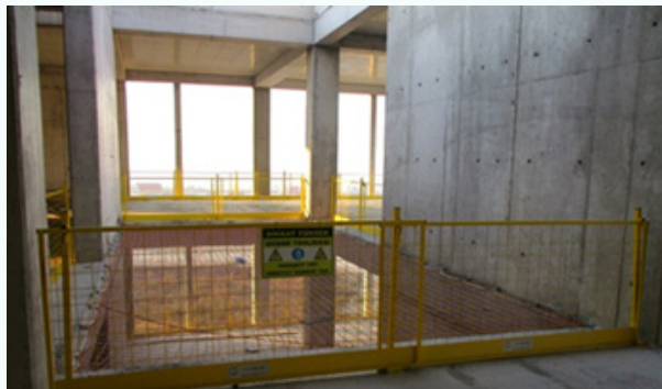
Beton imalatı sonrası uygulama. Post-concrete production application
